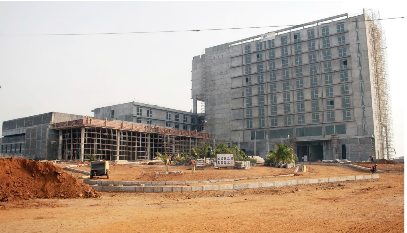
Projet de construction d'un hôtel à Cape Sierra - Freetown, Sierra Leone. Co-financé par la Banque
